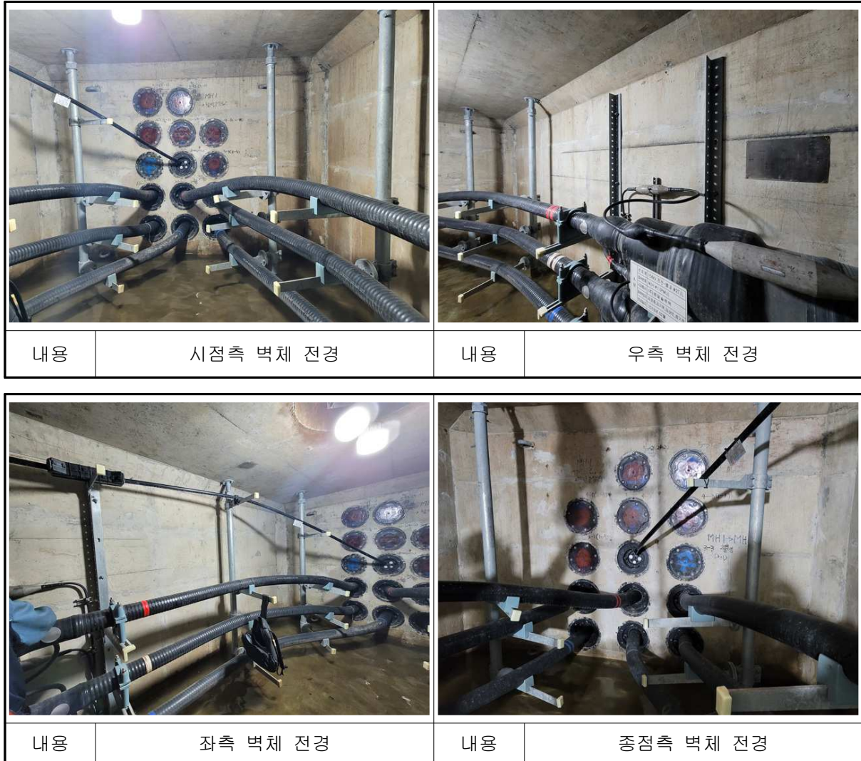
【사진 3.9】 진건~별내#1 전경
