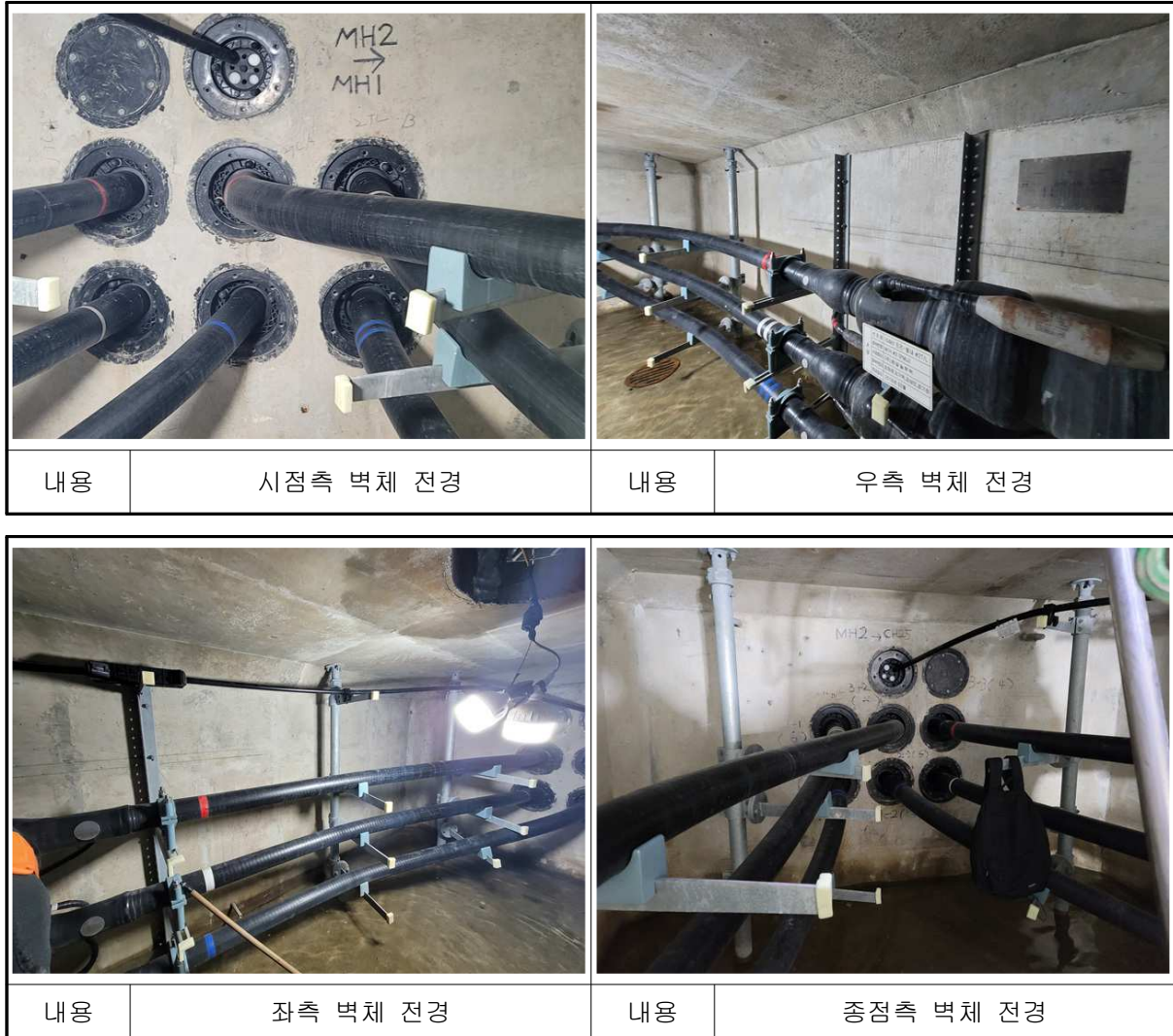
【사진 3.13】 진건~별내#2 전경
