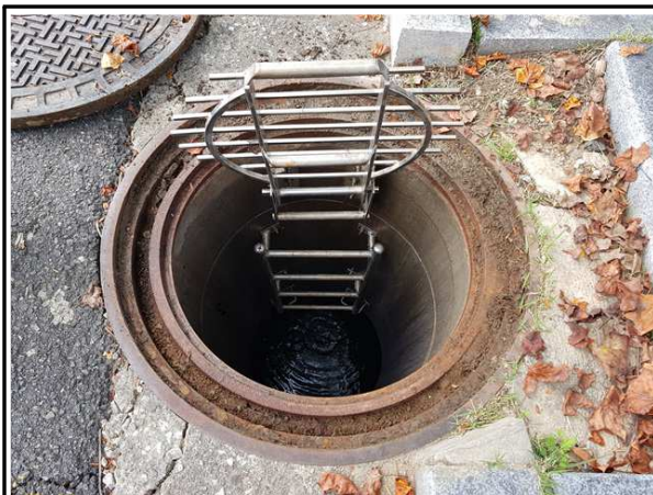
내용 추락방지시설 상태양호
