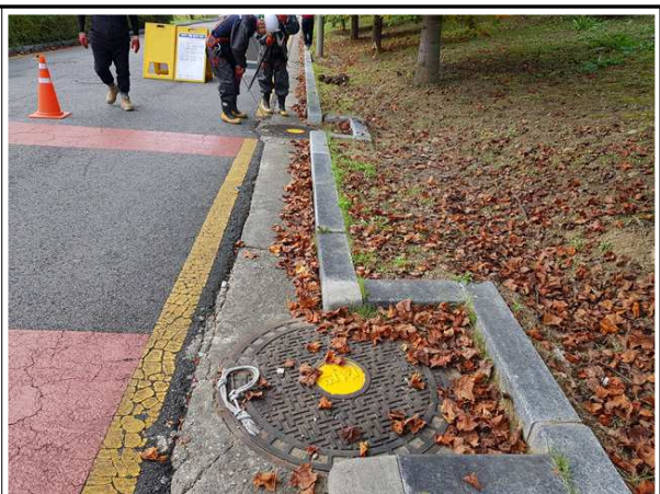
내용 도로포장 상태양호
